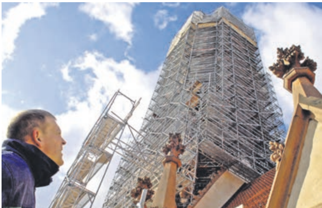
Ins Gerüst gefüllt: Der Jacobi-Kirchturm zu Beginn der Sanierungsarbeiten.
